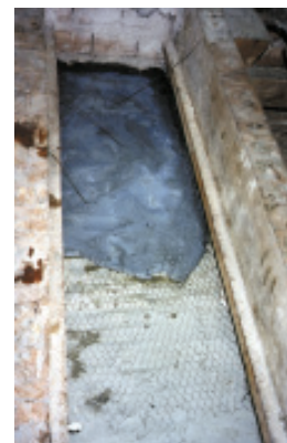
Foto 3: Detalhe dos tirantes de arame para armação nas traves superiores. Notar a rede metálica. Biblioteca FAU-Maranhão. Foto: Antonio Sarasá.
