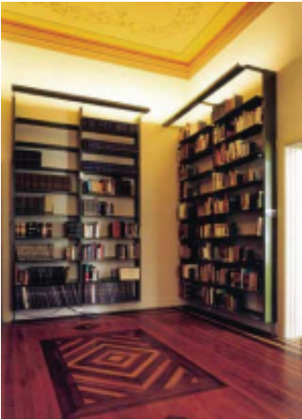
Fixação das prateleiras nas paredes liberou o piso da carga dos livros e liberou a visualização do forro e do assoalho Foto: Acervo Cristiano Mascaro
