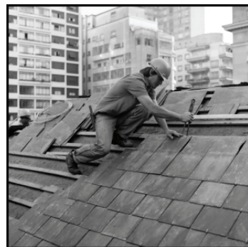
Foto 8: Posicionamento dos novos colchetes (de alumínio) nas ripas, para fixação das telhas de ardósia Foto: Osvaldo Gomes da Silva
