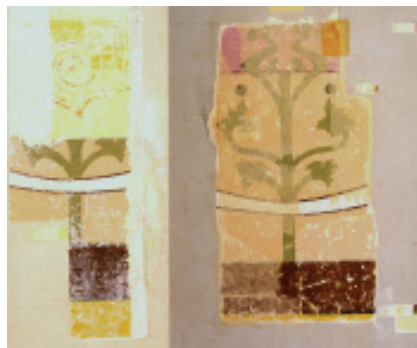
Figura 39: Áreas de decapagem de ambiente de acesso ao saguão principal (Casa A), que trouxeram a luz a pintura original de estilo art nouveau então recobertas com oito camadas de repinturas. Fotos: Roberto Bogo, 1992. Arquivo CPC-USP.
