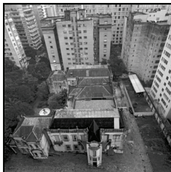
Foto 1: Vila Penteadó (FAU-Maranhão): Vista geral dos módulos dos telhados sendo reconstituídos (1º semestre de 1991) Foto: Osvaldo Gomes da Silva
