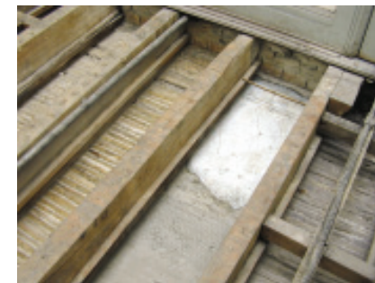
Foto 2: As várias fases da consolidação do forro: as fasquias de jissara limpas na parte superior, a emulsão de fixação do forro, e recomposição de argamassa superior, com tela metálica. Biblioteca FAU-Maranhão. Foto: Cândida Maria Vuolo.
