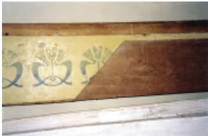
Foto 9: Moldura de madeira do friso superior. Biblioteca FAU-Maranhão. A recomposição foi feita com cavilhas de plástico, evitando-se peças de metal. Foto: Antonio Sarasá.
