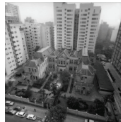
Foto 2: O que era fundos virou frente Foto: Autor não identificado
