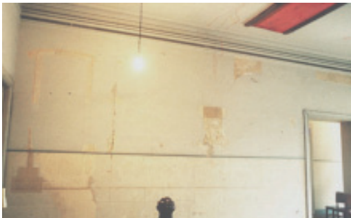
Figura 29: Área de sondagens estratigráficas verticais que comprovam que os arcos projetados por Carlos Ekman no saguão do pavimento superior foram construídos e entapumados em época indefinida. Demarcavam o corredor de circulação das dependências do Conde Álvares Penteado.
