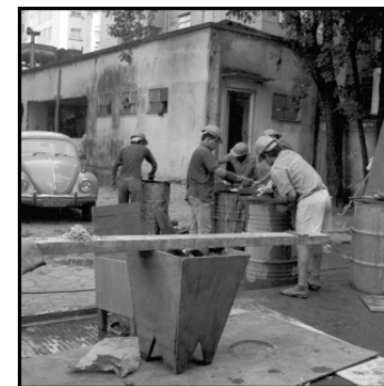
Foto 6: Canteiro de obras - ao fundo operários executando a lavagem individual das telhas, de acordo com especificações técnicas. À frente gabarito para dobradura de colchetes Foto: Osvaldo Gomes da Silva
