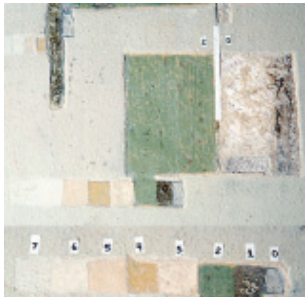
Figura 21: Abertura de faixa estratigráfica para identificação quantitativa das sobre pinturas.
