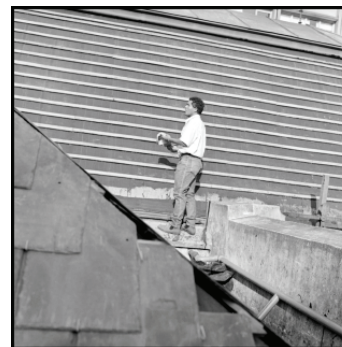
Foto 5: Detalhe externo de módulo de telhado. Chapas de compensado impermeabilizadas e o novo ripado já fixado Foto: Osvaldo Gomes da Silva
