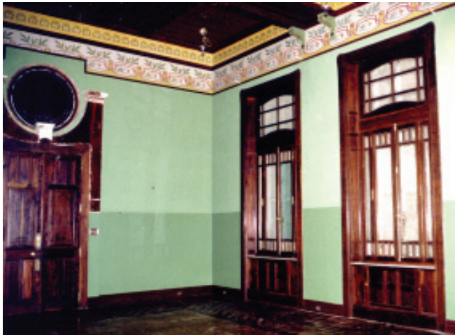
Figura 28: Sala de jantar restaurada em 1998 pelo Canteiro-Escola. Opção de restauro pela manutenção de monocromia verde nas paredes, em acordo com a tonalidade identificada como sendo a primeira das faixas estratigráficas abertas no cômodo. Descartou-se a hipótese de reaplicar papéis de parede, que se sabia existirem, para não criar falso histórico.
