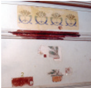
Figura 22: Decapagem de trechos que expõem a primeira pintura ornamental do ambiente.
