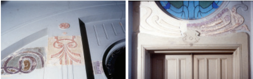
Figuras 33 e 34 : Áreas de decapagem no corredor de acesso a área social da Casa A (Álvares Penteado) que trouxeram à luz a pintura original sob oito camadas de repinturas. Fotos:Roberto Bogo.1992.Arquivo CPC-USP.
