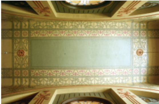
Figura 36: Forro do Módulo 1 do corredor de acesso a casa A após restauro. A paleta de cores predominante é composta das cores ocre, vermelho, verde e azul, que se repete em detalhes de pavimento de mosaicos no mesmo ambiente. Foto: Ângela Garcia, 1996. Arquivo CPC-USP
