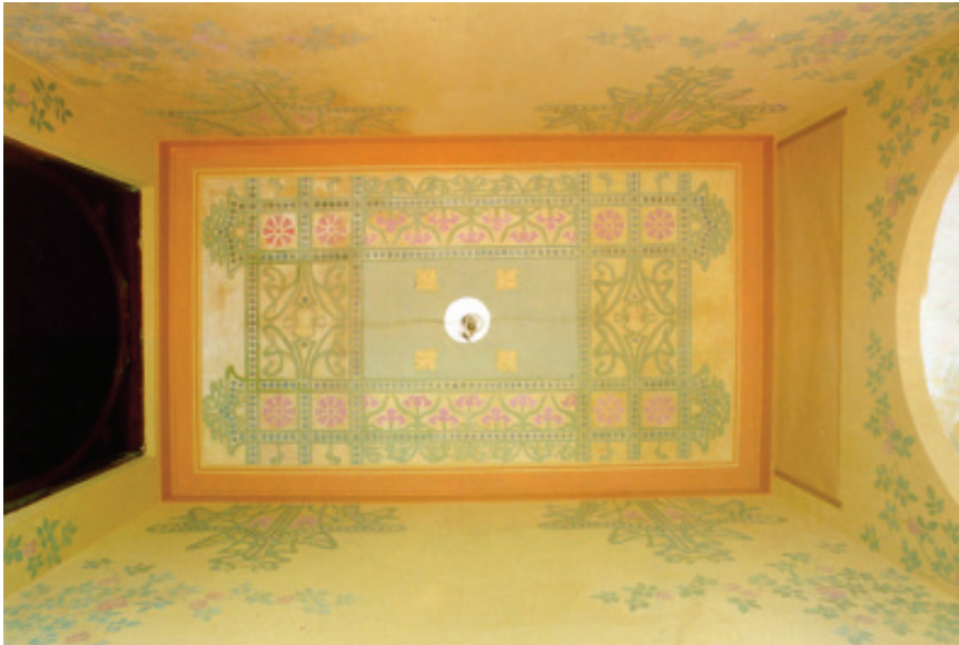
Figura 37: Forro do Módulo 2 do corredor de acesso a Casa A aos restauro Foto: Ângela Garcia.1996.Arquivo CPC-USP.
