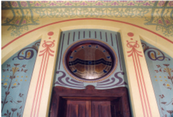
Figuras 33 e 34 : Áreas de decapagem no corredor de acesso a área social da Casa A (Álvares Penteado) que trouxeram à luz a pintura original sob oito camadas de repinturas. Fotos:Roberto Bogo.1992.Arquivo CPC-USP.
