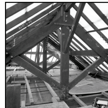
Foto 4: Vista interna do sótão em um dos módulos da cobertura: detalhe da estrutura em madeira constituída de tesouras, vigas, terças e caibros em bom estado Foto: Osvaldo Gomes da Silva
