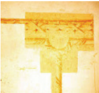
Figura 30: Detalhe de "janela de prospecção" com trecho de pintura ornamental correspondente ao " Segundo Período Decorativo " da casa.
