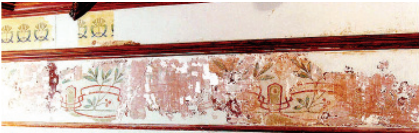
Figura 23: Barramento ornamental com motivo de planta de café durante trabalho de decapagem.
