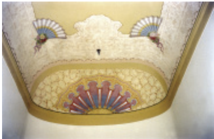
Foto 11: Sala dos leques. Biblioteca FAU-Maranhão. Nesta sala, a intervenção de restauro após a decapagem foi mínima, restringindo-se à faixa que supõe-se destruída por intervenção posterior à inauguração do prédio, e algumas rachas no revestimento das paredes. Foto: Antonio Sarasá.
