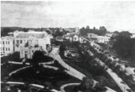
Foto 2 - Vila Penteados, início da segunda década do século XX. Nesta imagem, a paisagem é acrescida de novos volumes edificadas, como a Vila Hell, o anexo da Vila Penteados etc. Arquivo: FAUUSP
