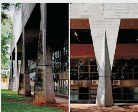
Detalhe da fachada revela o contraste entre o peso do volume e seus leves pontos de apoio: pilares em forma de triplicios duplos. Falta de vigas-garêde de concreto armado, as empresas servem também para vedar os estúdios e os salões de aula. Recuperada, a superfície de tais estruturas tem hoje aparência bem diferente da anterior (foto: a seguir, manchaçada e danificada).
