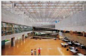
Panorâmica revela salas, rampas, estudos e praça central amplamente iluminadas, graças ao resgate dos 960 domos da cobertura, os quais oferecem iluminação zenital.
