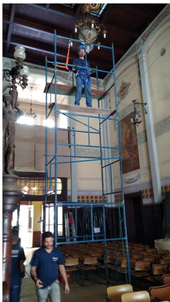
Fotos 5 - Recuperação de instalações elétricas do lustre no saguão principal. Autor: Thiago Silva (SEF USP).
